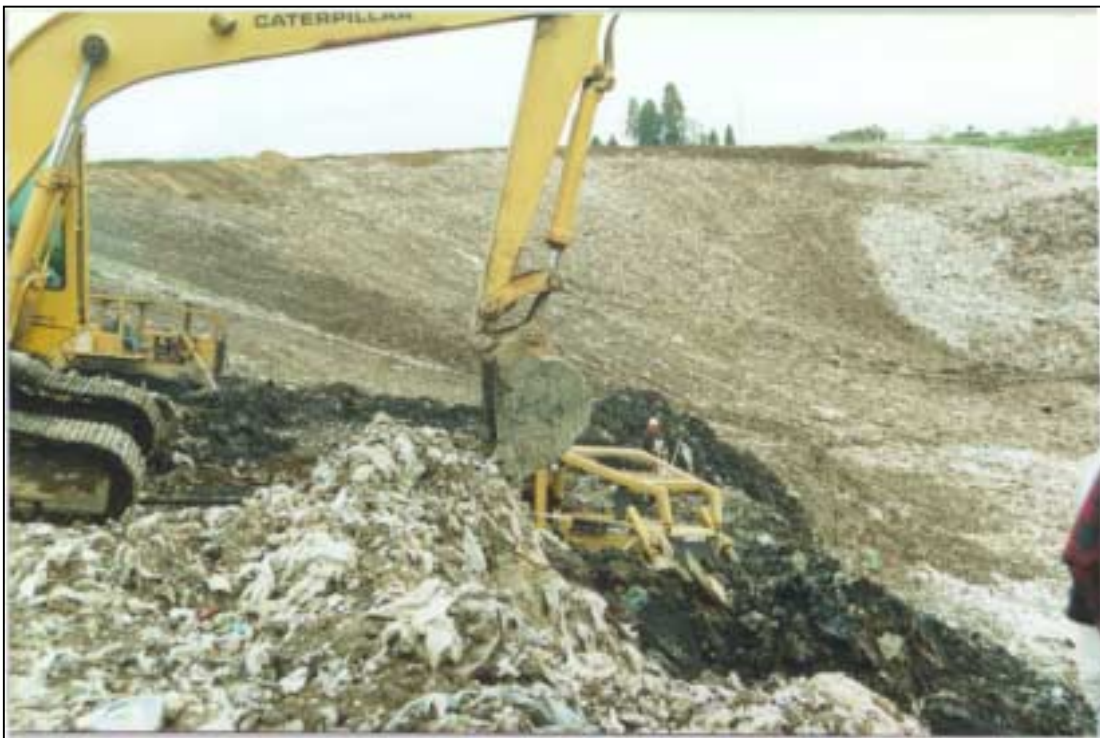
Figura 5: Metepec después de la rehabilitación.
