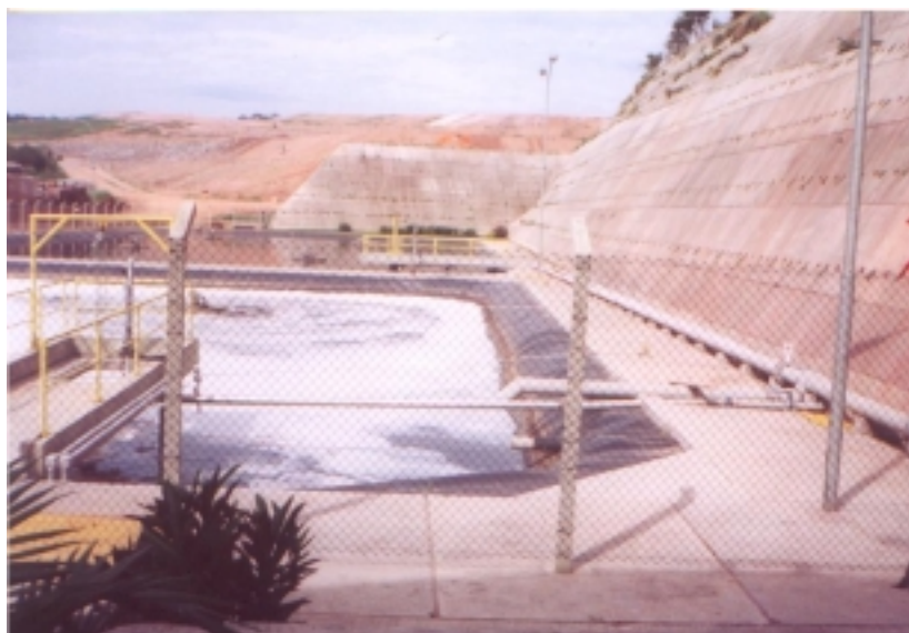
Figura 6 - Estação de tratamento (2 lagoas facultativas) – Mauá – São Paulo
