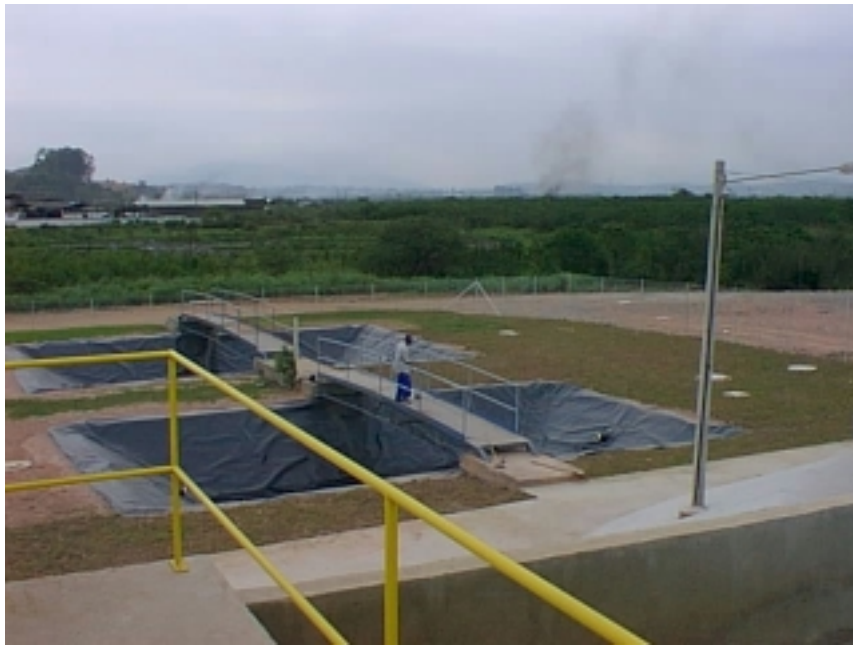
Figura 7 –Tanques de polimento, sistema de nano-filtracao – Gramacho – Rio de Janeiro
