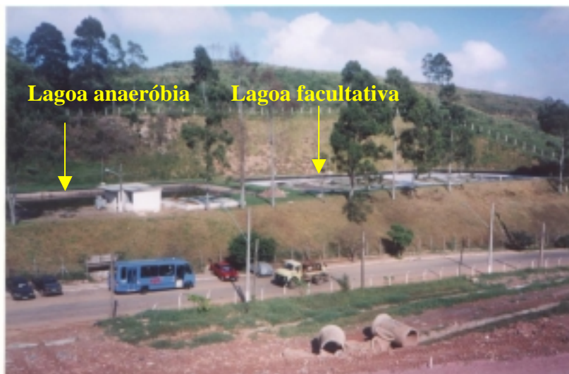
Figura 5 – Estação de tratamento – Santo André – São Paulo
