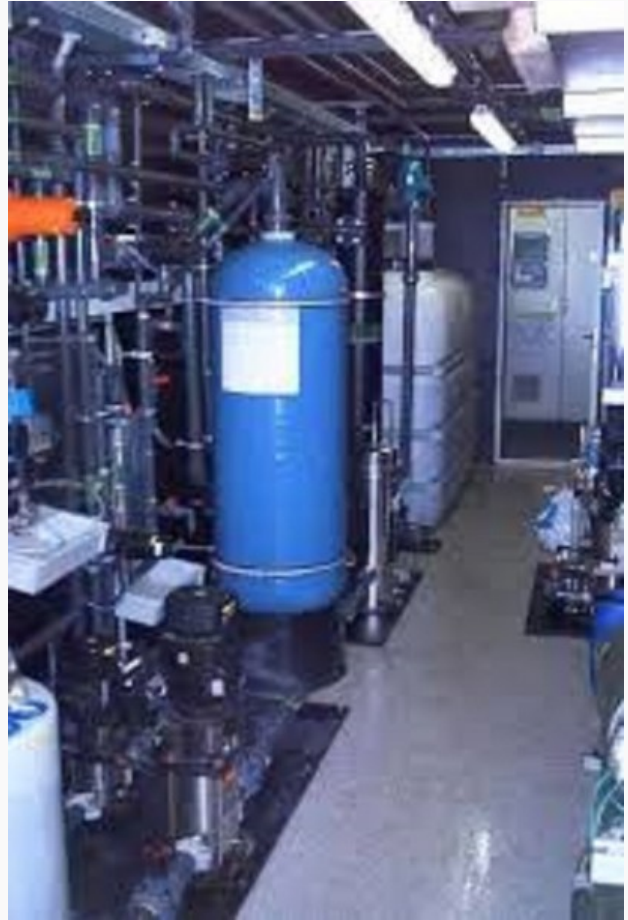
Sistema específico para o tratamento de chorume
