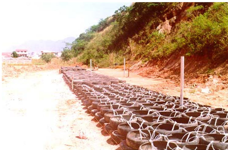
Figura 5 – Estágio intermediário e detalhe da amarração com corda de polipropileno
