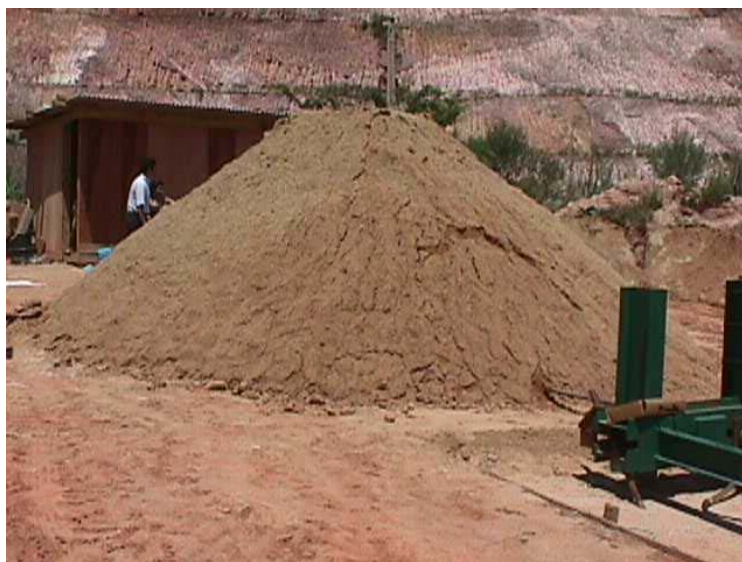
Figura 16 – Vista do Aterro Durante Ensaio
