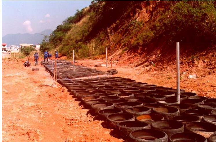
Figura 4 – Estágio inicial da construção do muro: posicionamento da 1ª camada de pneus
