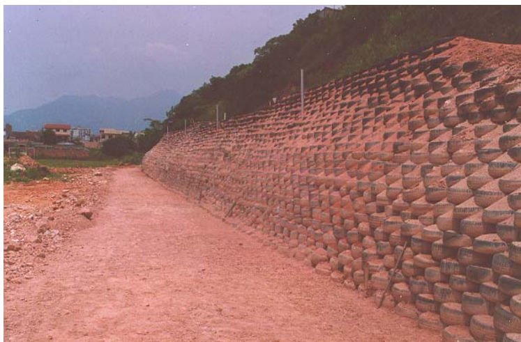
Figura 6– Final da construção do muro.
